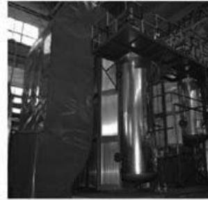
图4 联通式热管余热锅炉
